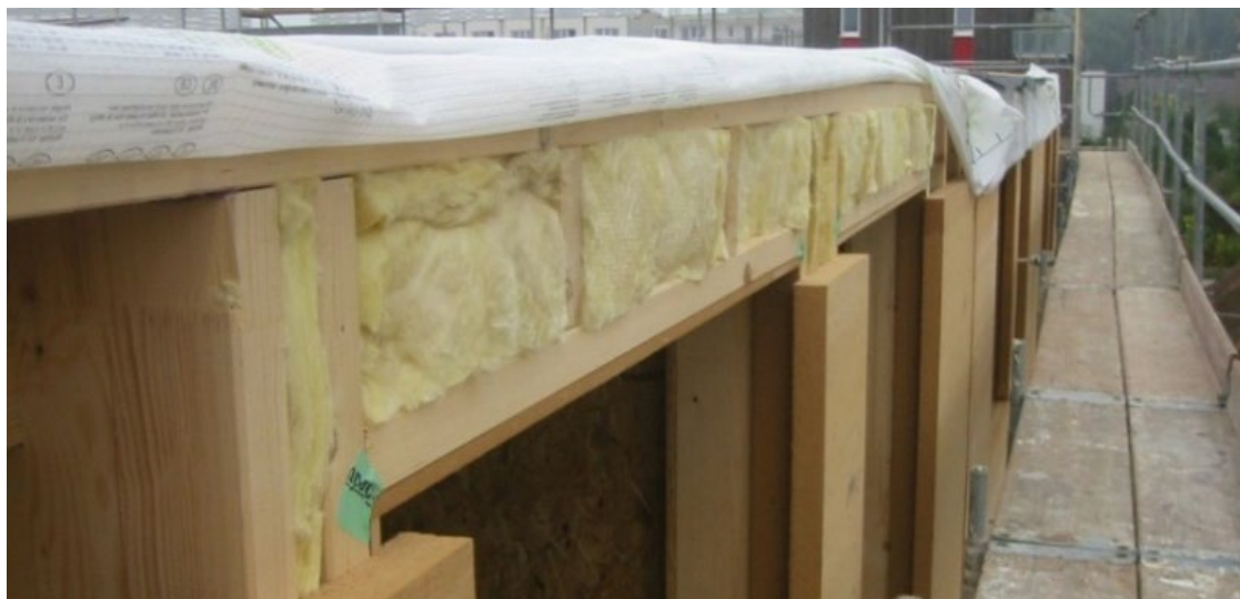
Figur 2 Isolasjon med mineralullisolasjonsmaterialer.
