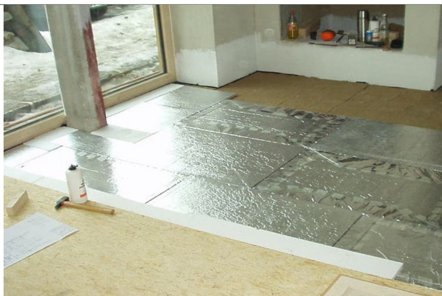
Figur 6 Isolasjon av gulv med vakuumisolasjonspaneler.
