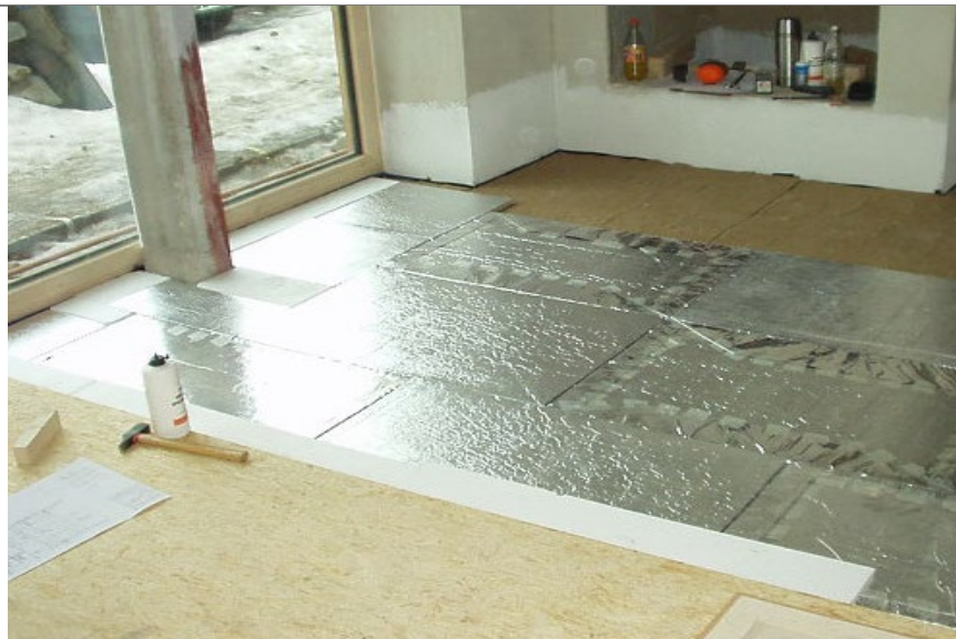
Figura 6. Aislamiento de suelos con paneles de aislamiento al vacío.
