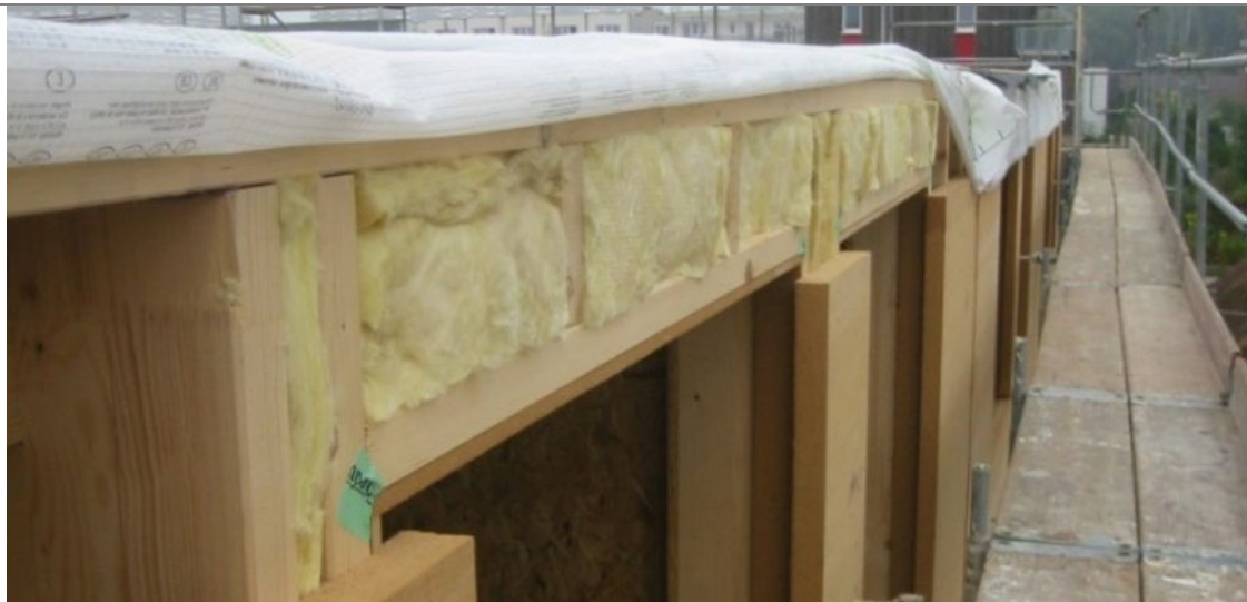
Figura 2 Aislamiento con materiales aislantes de lana mineral.
