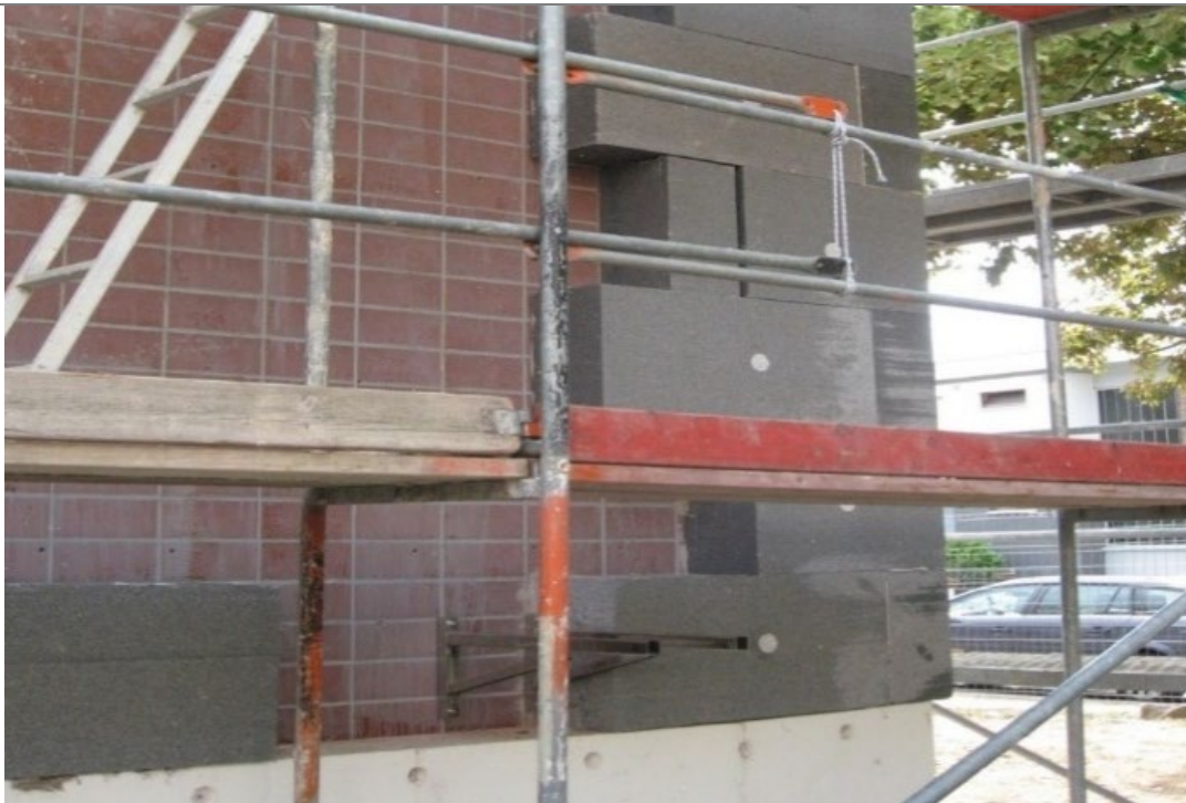
Figura 4. Aislamiento de las paredes de un edificio con paneles de espuma de poliestireno (Neopor).
