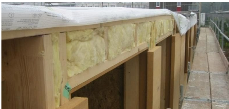
Figura 2 Izolație cu materiale izolante din vată minerală.
