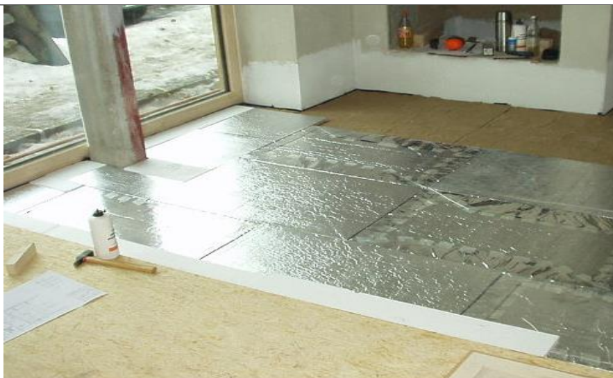
Pav. 6 Grindų šiltinimas vakuminėmis izoliacijos plokštėmis.
