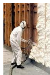
©Spumă poliuretanică pulverizată
