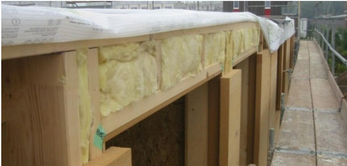
Figur 2 Isolasjon med mineralullisolasjonsmaterialer.
