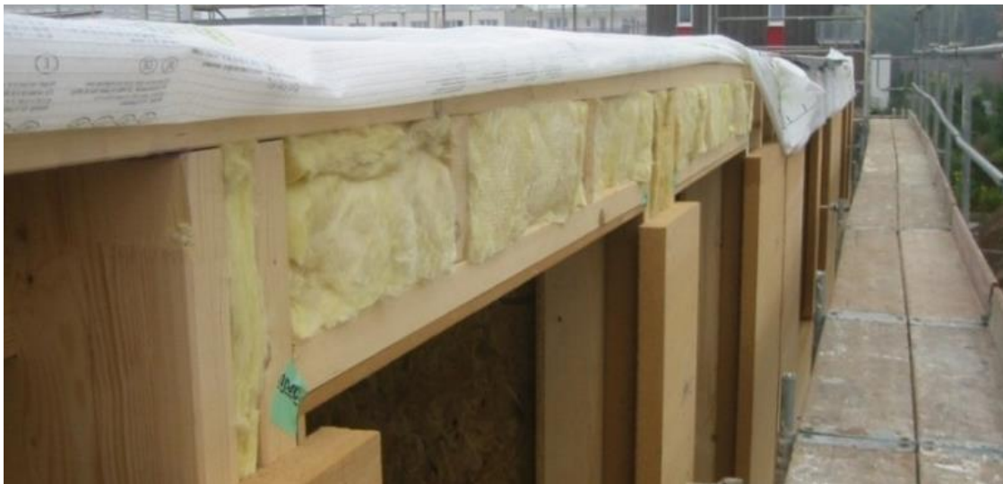
Pav. 2 Šiltinimas mineralinės vatos izoliacinėmis medžiagomis.
