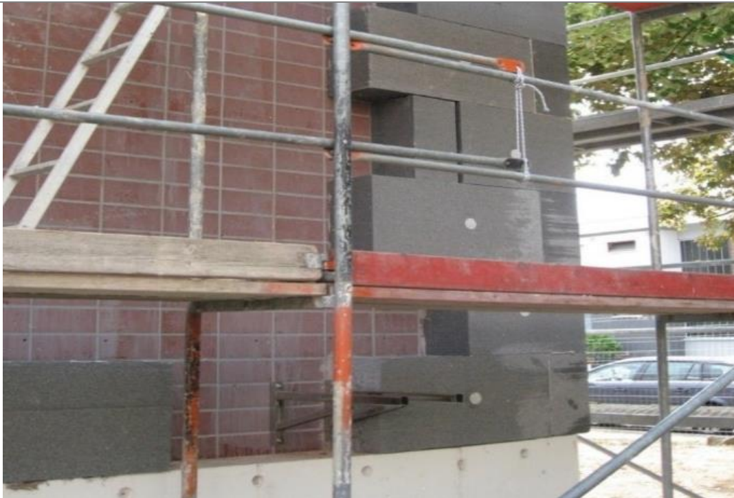
Pav. 4 Pastato sienų šiltinimas polistireninio putplasčio (Neopor) plokštėmis.
