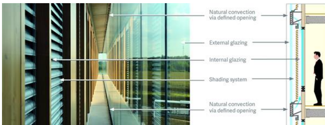
9 pav. Dvigubo sluoksnio fasadas.
