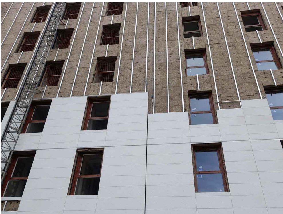
Figura 16: Rehabilitación energética de la fachada. Fachada ventilada
