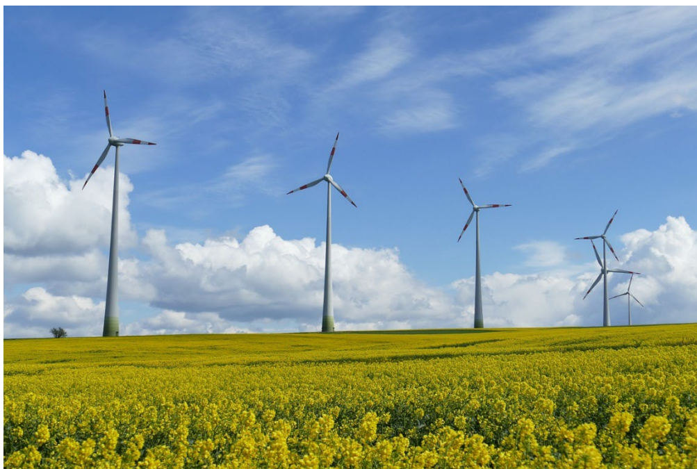
Figur 9. Eksempel på vindturbiner.
