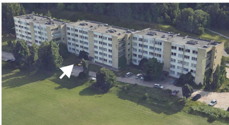
Figura 2: Edificio residencial de cinco plantas en Lituania
