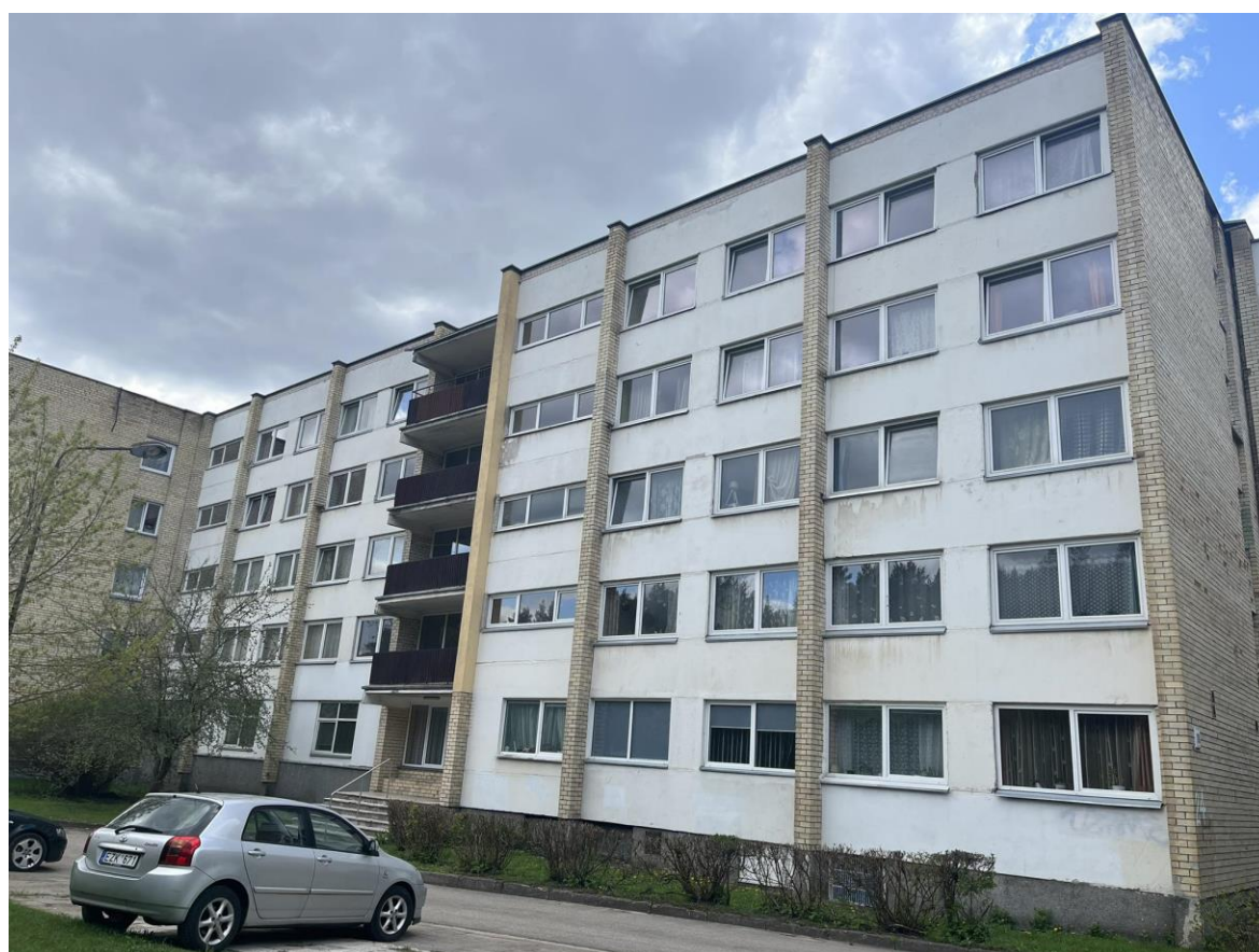
Imaginea 7 Fațada estică.
