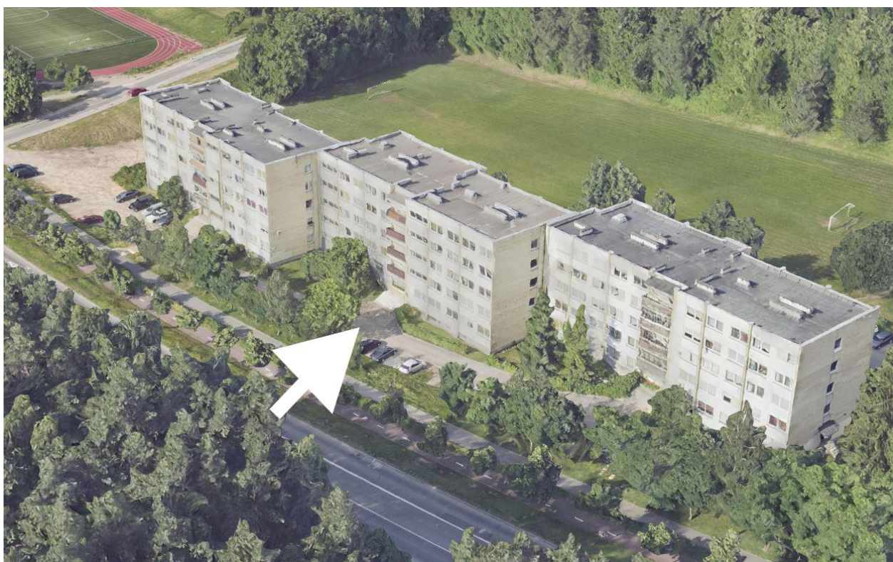
Imaginea 3 Fațada estică.
