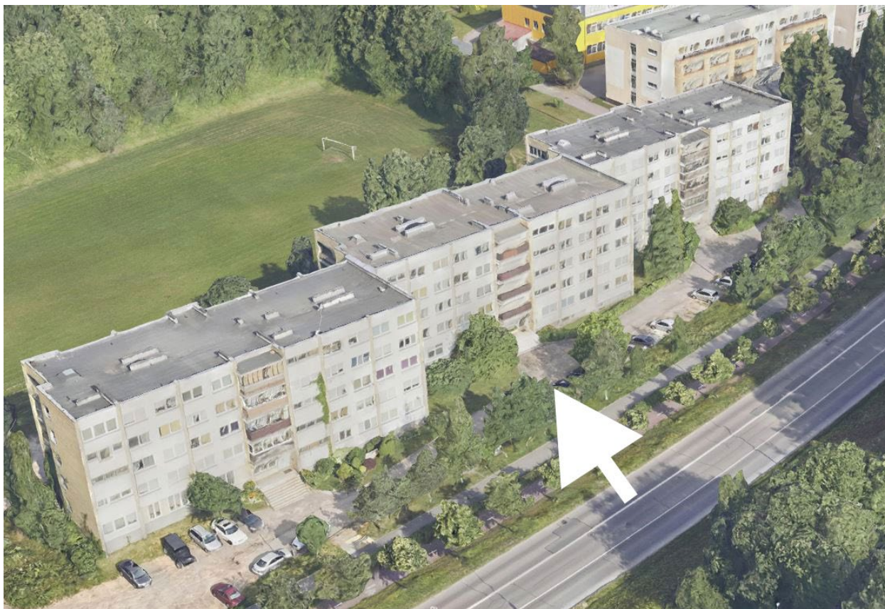
Imagen 2 Fachada este y entrada principal.
